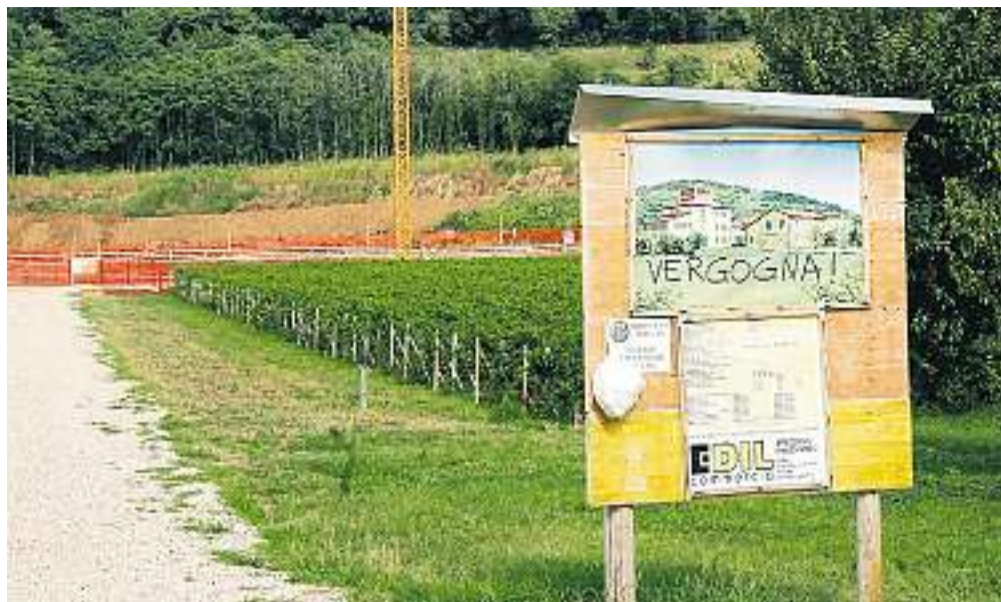
Il cantiere sotto Forte John a Ponte Florio: l'edificio rustico non c'è più FOTO MARCHIORI
